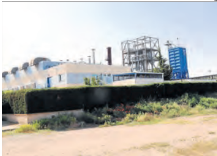
Imatge d'arxiu de les instal·lacions de Tracjusa a Juneda.
